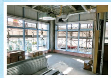
建物内部の様子
