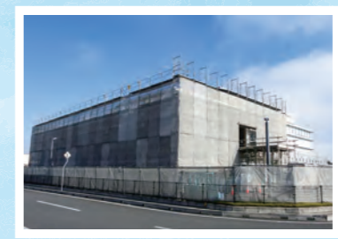
外壁足場が組みあがった外観
